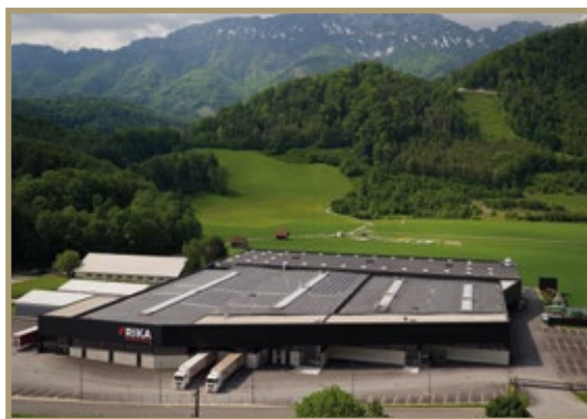
RIKA Entreprise de Métallurgie
